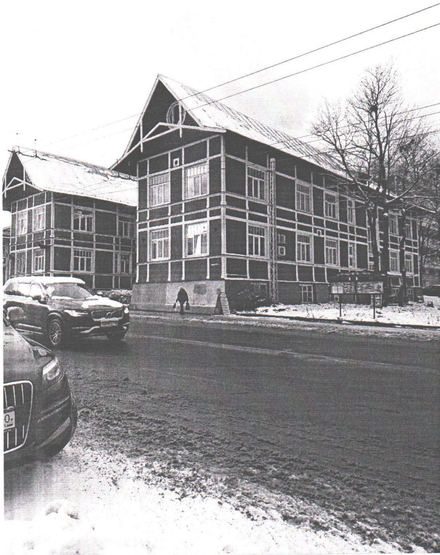
«Здание административное» Республика Карелия, г. Петрозаводск, пр. Ленина, д. 22-а Общий вид с юго-востока Дата: 29.10.2019
