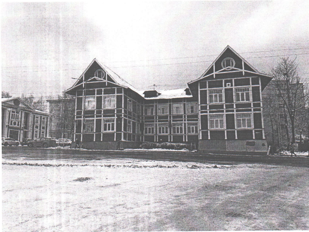
«Здание административное» Республика Карелия, г. Петрозаводск, пр. Ленина, д. 22-а Вид на фасад со стороны просп. Ленина Дата: 29.10.2019
