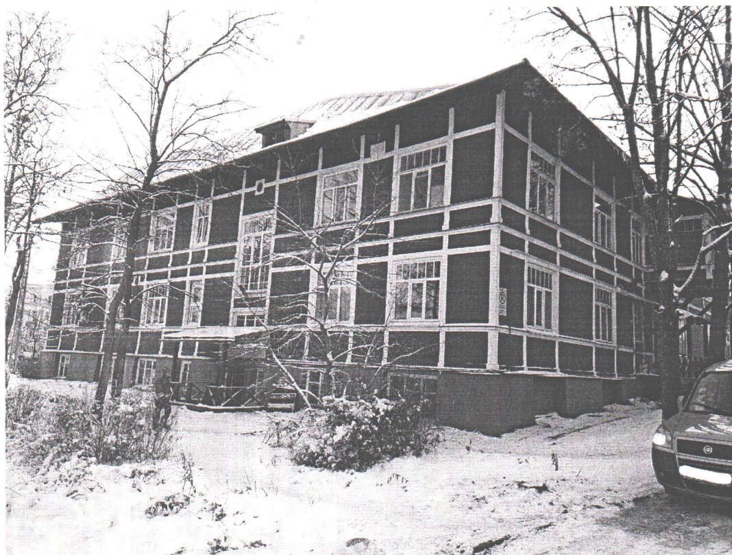
«Здание административное» Республика Карелия, г. Петрозаводск, пр. Ленина, д. 22-а Общий вид с севера Дата: 29.10.2019
