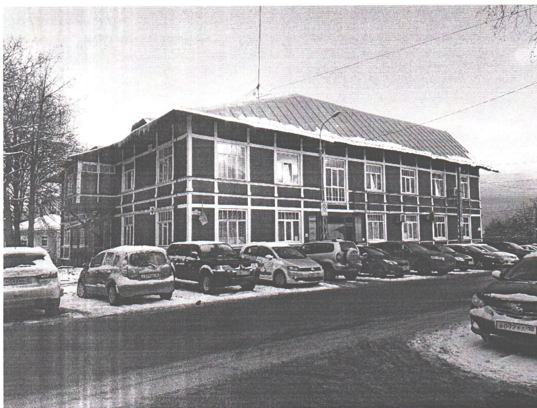
«Здание административное» Республика Карелия, г. Петрозаводск, пр. Ленина, д. 22-а Вид на фасад со стороны ул. Энгельса Дата: 29.10.2019
